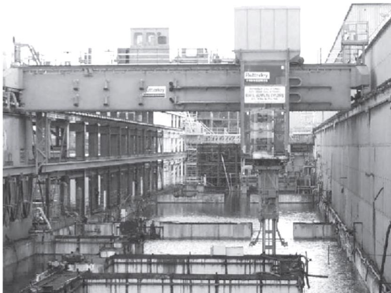
شکل ۹-۵. حوضچه انبارش متروک ماگنوکس در سلافیلد، انگلستان.
